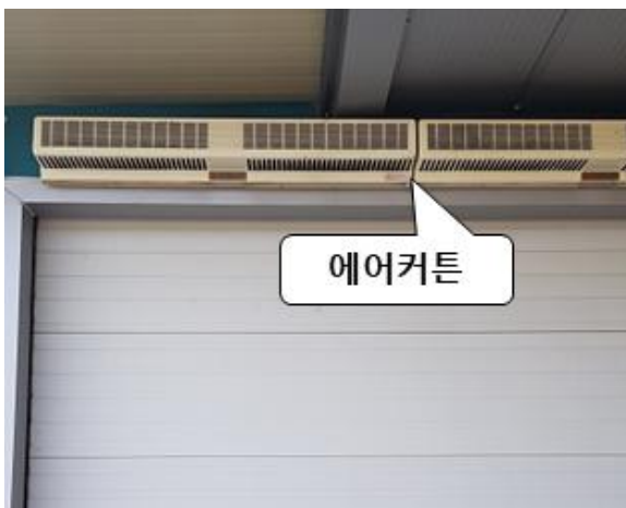
외부 출입문에 에어커튼 설치
